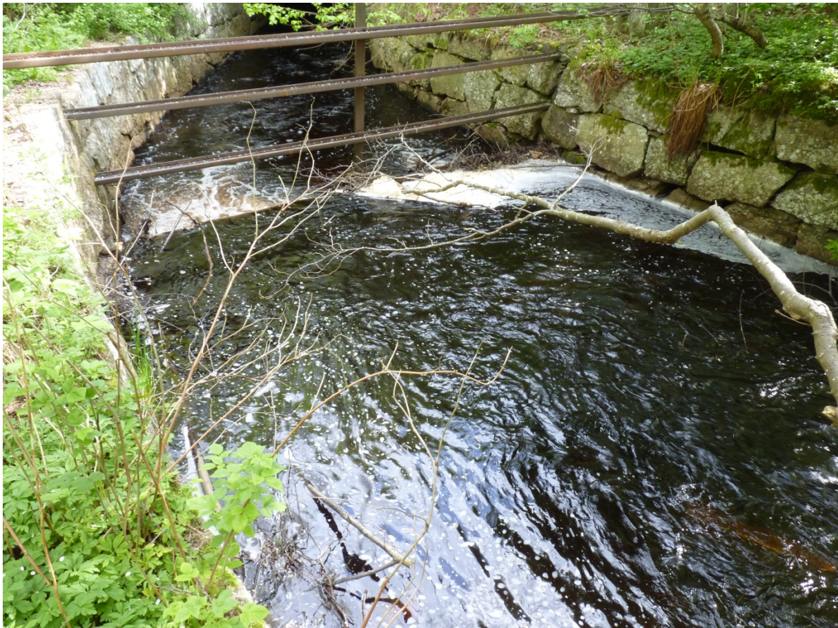
Figur 11. Stålkonstruktionen i Hökesån, uppströms järnvägstunneln.
