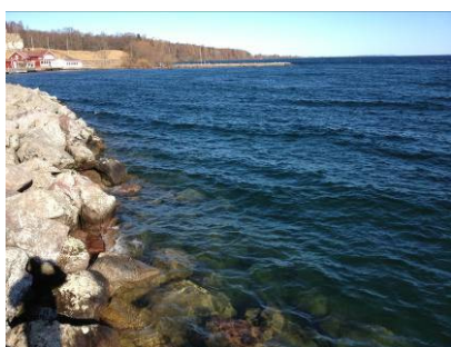
Figur 22. Merparten av den norra vågbrytaren bestod av stora block, vilka tidvis uppgick till 2 meter.
