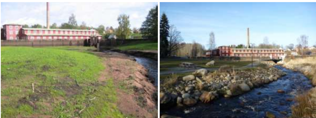
Figur 17. Färgeridammen i Hökesån före och efter utrivningen sommaren/hösten 2010 (foto: Per Sjöstrand och Peter Lindvall, Jönköpings Fiskeribiologi AB).
