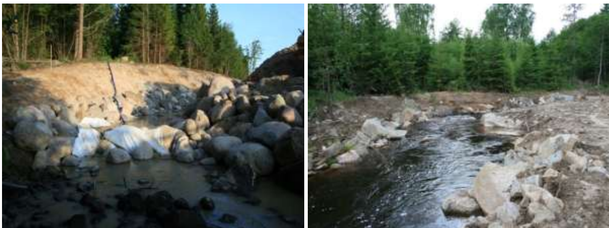
Figur 3. Omlöpet vid Skårhultsdammen i Knipån som anlades under perioden mars-juli 2009 (foto: Per Sjöstrand, Jönköpings Fiskeribiologi AB).
