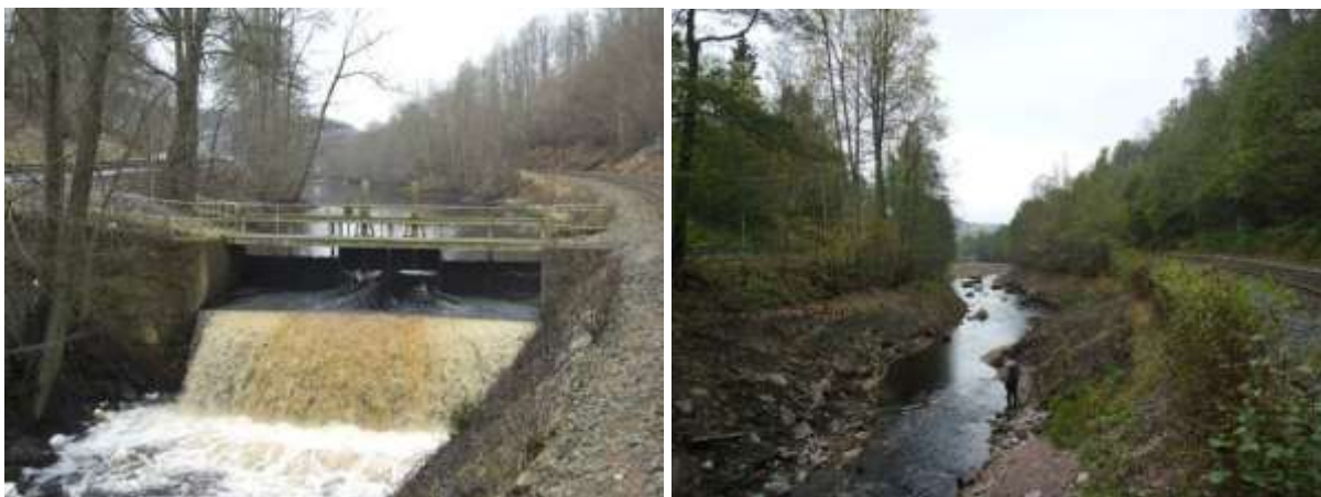
Figur 41. Massadammen i Tabergså före och efter utrivningen vintern 2010 till hösten 2011 (foto: Per Sjöstrand och Peter Lindvall, Jönköpings Fiskeribiologi AB).
