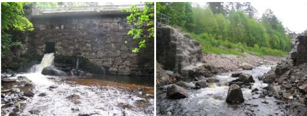
Figur 40. Hökhultsdammen i Tabergså före och efter utrivningen våren 2005 (foto: Per Sjöstrand, Jönköpings Fiskeribiologi AB).
