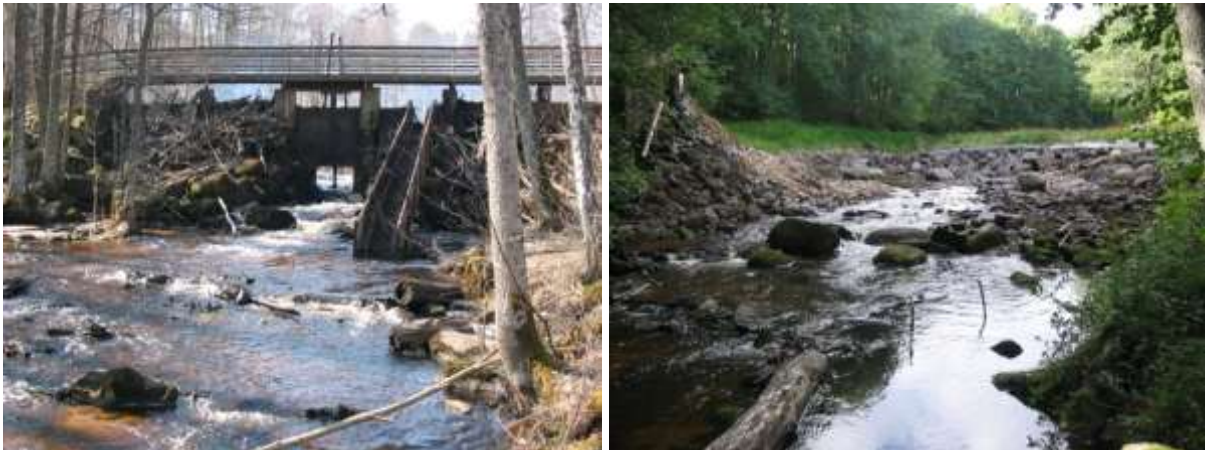
Figur 16. Laggaredammen i Hökesån före och efter utrivningen hösten 2005 (foto: Per Sjöstrand, Jönköpings Fiskeribiologi AB).
