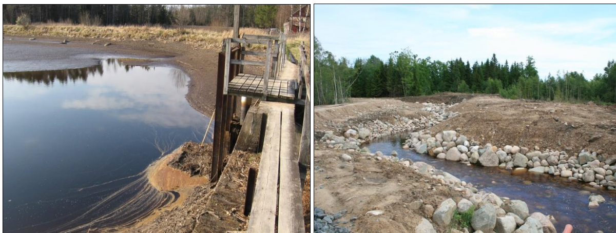
Figur 5. Dammen (avsänkt) och omlöpet vid Skårhultsdammen i Knipån (foto: Niklas Nilsson, Jönköpings Fiskeribiologi AB).
