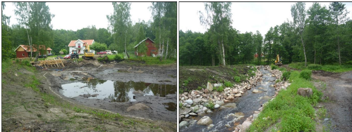
Figur 6. Dammen (avsänkt) och omlöpet vid Gäbo kvarn i Knipån (foto: Peter Lindvall, Jönköpings Fiskeribiologi AB).
