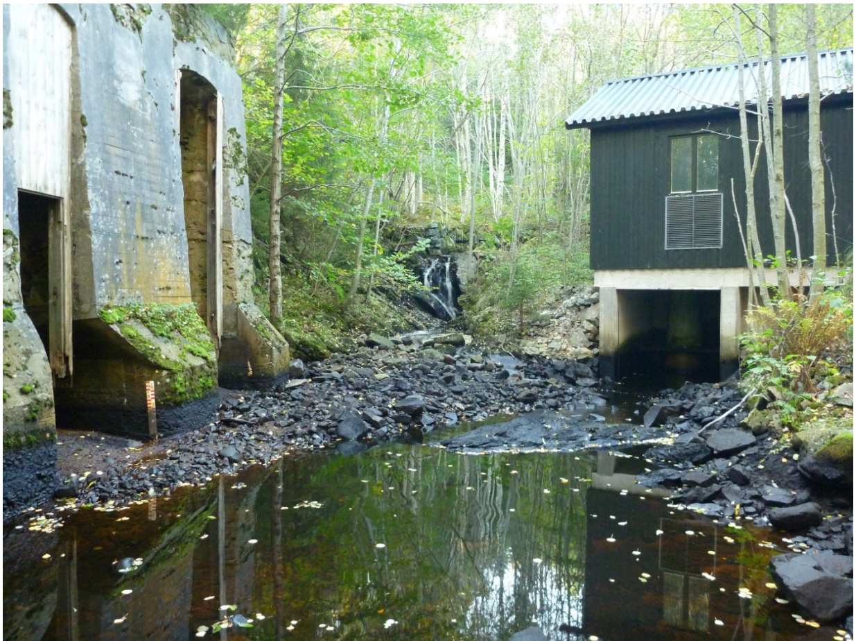
Baskarps kraftverk vid driftstopp med torrfåran till vänster
