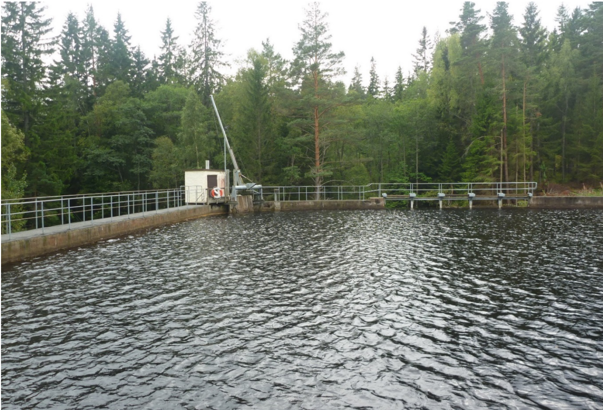
Dammfästet i Fjällbölsdammen med turbinintag (vid lilla huset) och yttskov (till höger i bild)
