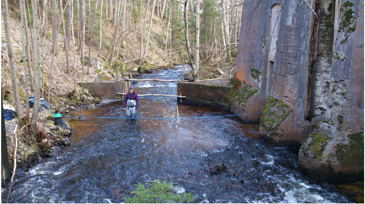
Station 3 vid Baskarps kraftverk.
