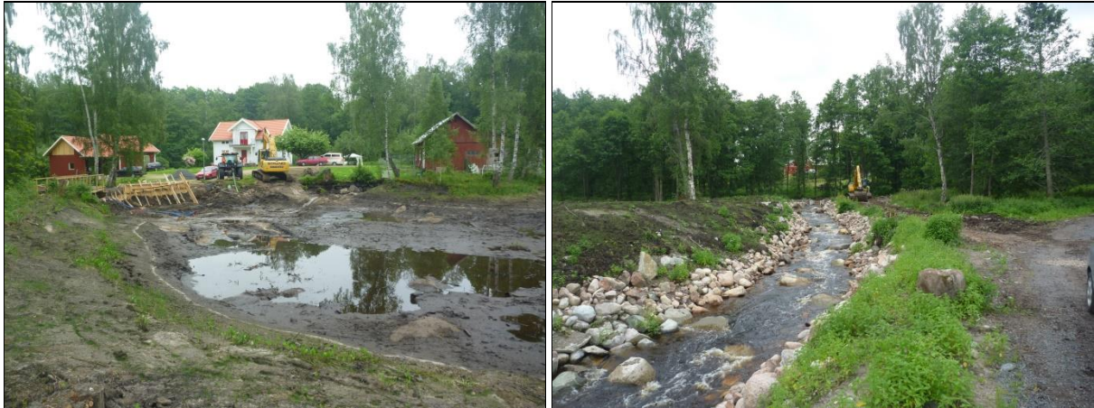
Figur 6. Dammen (avsänkt) och omlöpet vid Gäbo kvarn i Knipån (foto: Peter Lindvall, Jönköpings Fiskeribiologi AB).
