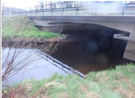
2-7 m uppstr. Vägbron. Sydöstra sidan.
