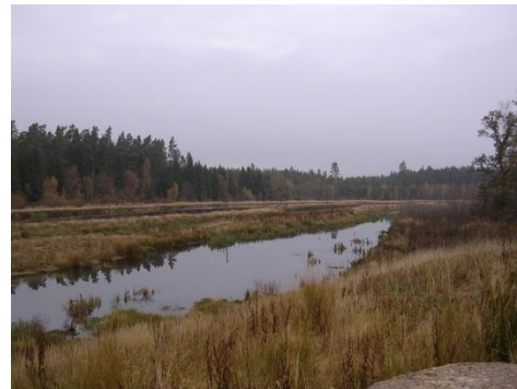
Figur 69. Dagvatten från Habo tätort efterpoleras i våtmarkskomplex/dammar innan det når Vättern.
