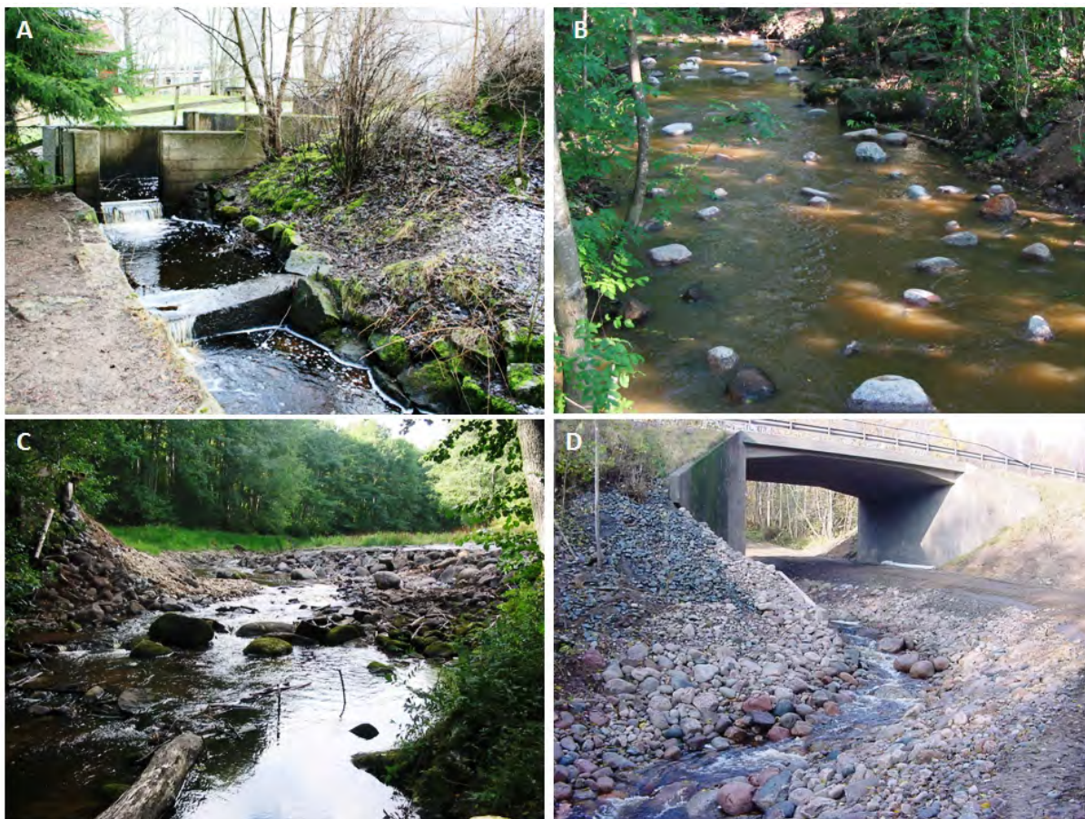
Figur 14. Exempel på genomförda fiskevårdsåtgärder i Vätterns tillflöden. Bassängtrappa i Tabergsån (A), Biotopvård i Hökesån (B), utrivning av Laggaredammen i Hökesån (C) och omlöp under väg 195 i Skänningforsån (D). Foto: Länsstyrelsen i Jönköpings läns arkiv och Per Sjöstrand, Jönköpings Fiskeribiologi.
