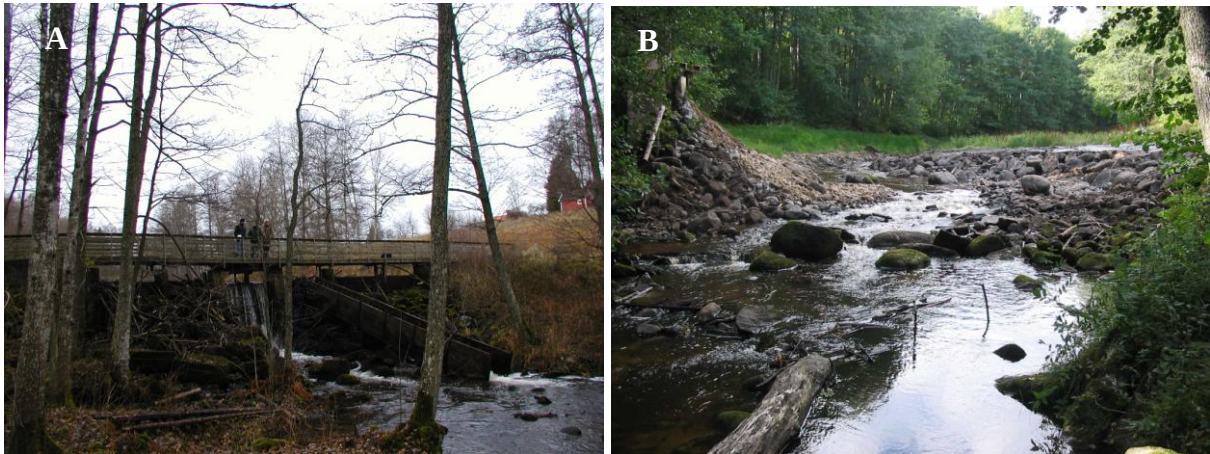
Figur 21. Laggaredammen i Hökesån i centrala Habo innan (A) respektive efter (B) utrivning 2004 (arkivfoto Länsstyrelsen i Jönköpings län och Per Sjöstrand).
