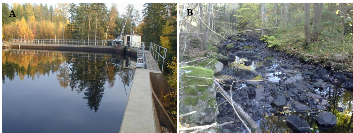
Figur 6. Kraftverksdammen i Svedån, A (arkivfoto Länsstyrelsen i Jönköpings län) och torrlagd åfåra vid nolltappning i Svedån, B (foto Peter Bratt).
