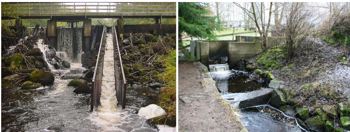
Figur 22. Denilränna vid den numera utrivna Laggaredammen i Hökesån (A) och bassängtrappa (B) vid Hovslätt i Tabergsån (foto Per Sjöstrand).
