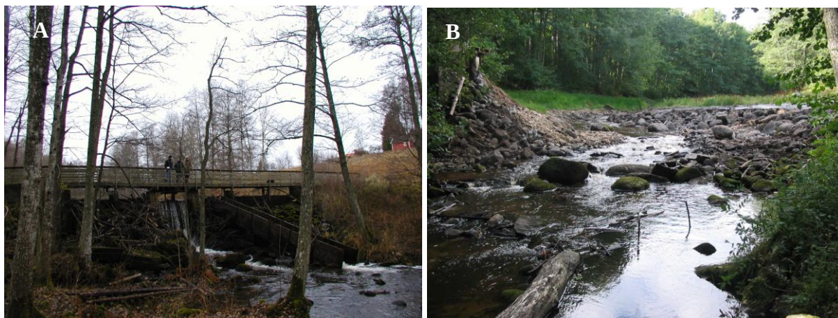
Figur 21. Laggaredammen i Hökesån i centrala Habo innan (A) respektive efter (B) utrivning 2004 (arkivfoto Länsstyrelsen i Jönköpings län och Per Sjöstrand).
