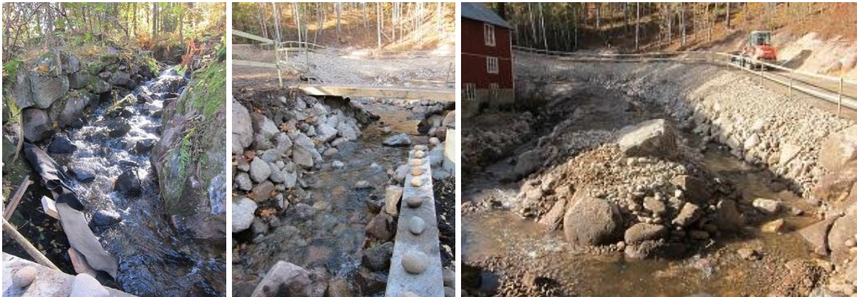
Figur 2. Exempel på genomförda åtgärder vid anläggning av omlöp i Rödån, Habo kommun 2013. Foto: Länsstyrelsen i Jönköpings län/Jönköpings Fiskeribiologi AB.
