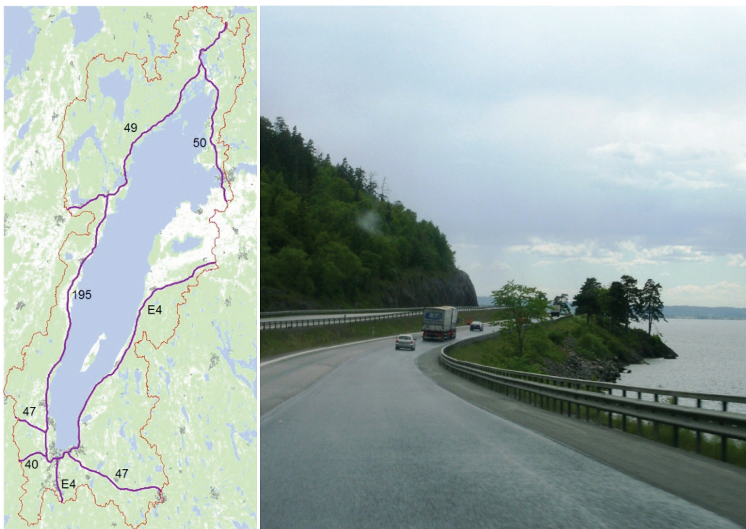
Figur 12. De större vägarna inom Vätterns avrinningsområde som ingår i skattningen av emissionerna av metaller från trafik: E4 nära stranden längs den östra kusten, riksvägarna 40, 47, 49 och 50, samt länsväg 195. Bilden till höger visar trafik på E4 vid Vätterns strand.
