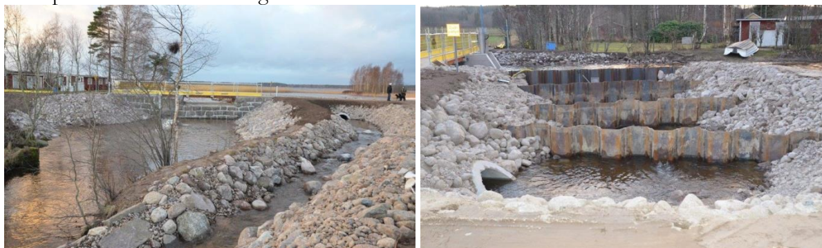
Figur 10. Bilden illustrerar en del i ett lyckat restaureringsprojekt som syftar till att tillgängliggöra hela Hjoån för den sjölevande öringen i Vättern. Under slutet av 2015 färdigställdes den sista fiskvägen vid "stämmorna" i Hjoån. Den sjölevande öringen i Vättern har nu tillgång till hela åns sträckning. Öringen kan genom denna åtgärd nå historiska lek-områden uppströms Mullsjön, områden som tidigare varit oåtkomliga till följd av definitiva vandringshinder (foto: Hans-Göran Hansson).
