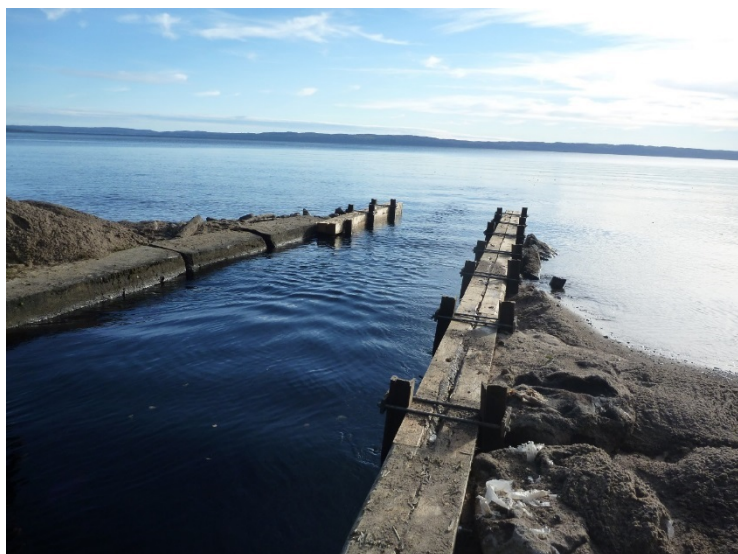
Figur 6. Hornåns mynning med de anlagda strömkoncentratorerna vilka förhindrar att sand täpper igen mynningen och att fisk har möjlighet att vandra även vid mycket låga flöden (foto: Länsstyrelsen i Jönköping).
