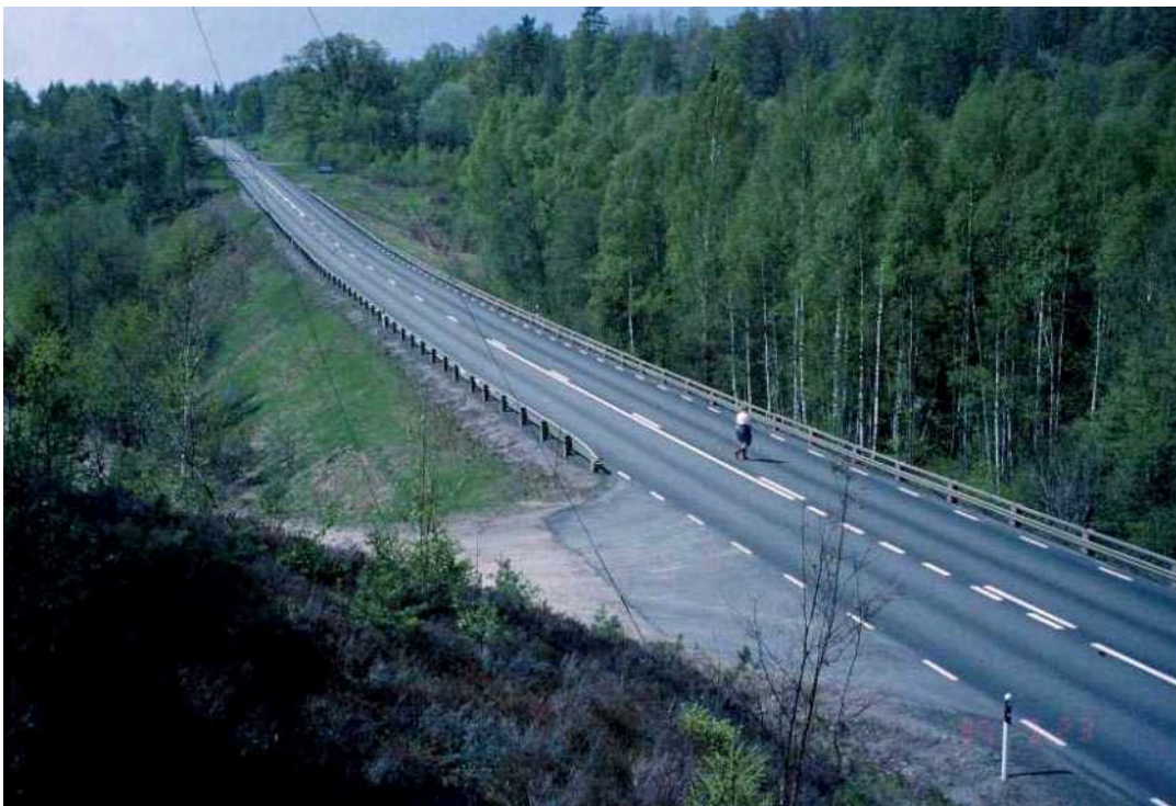
Figur 3. Väg 195 passerar på bank över flera raviner. Ibland går det ett vattendrag i botten.
