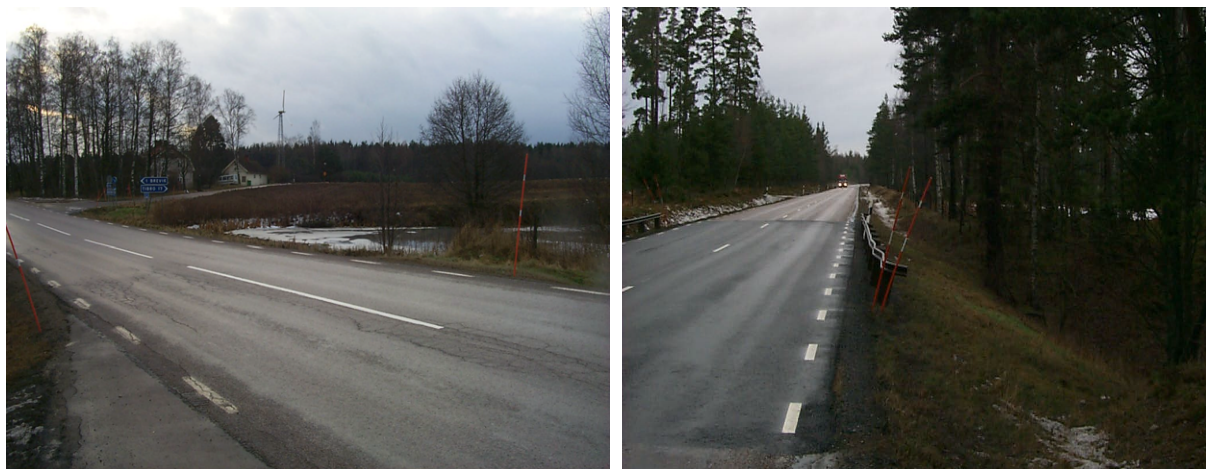
Figur 7. Exempel på vattendragspassager där antingen räcke saknas (bilden till vänster, Hinsegårdsbäcken) eller där befintligt räcke inte täcker hela ravinen (bilden till höger, Söderrydsbäcken).
