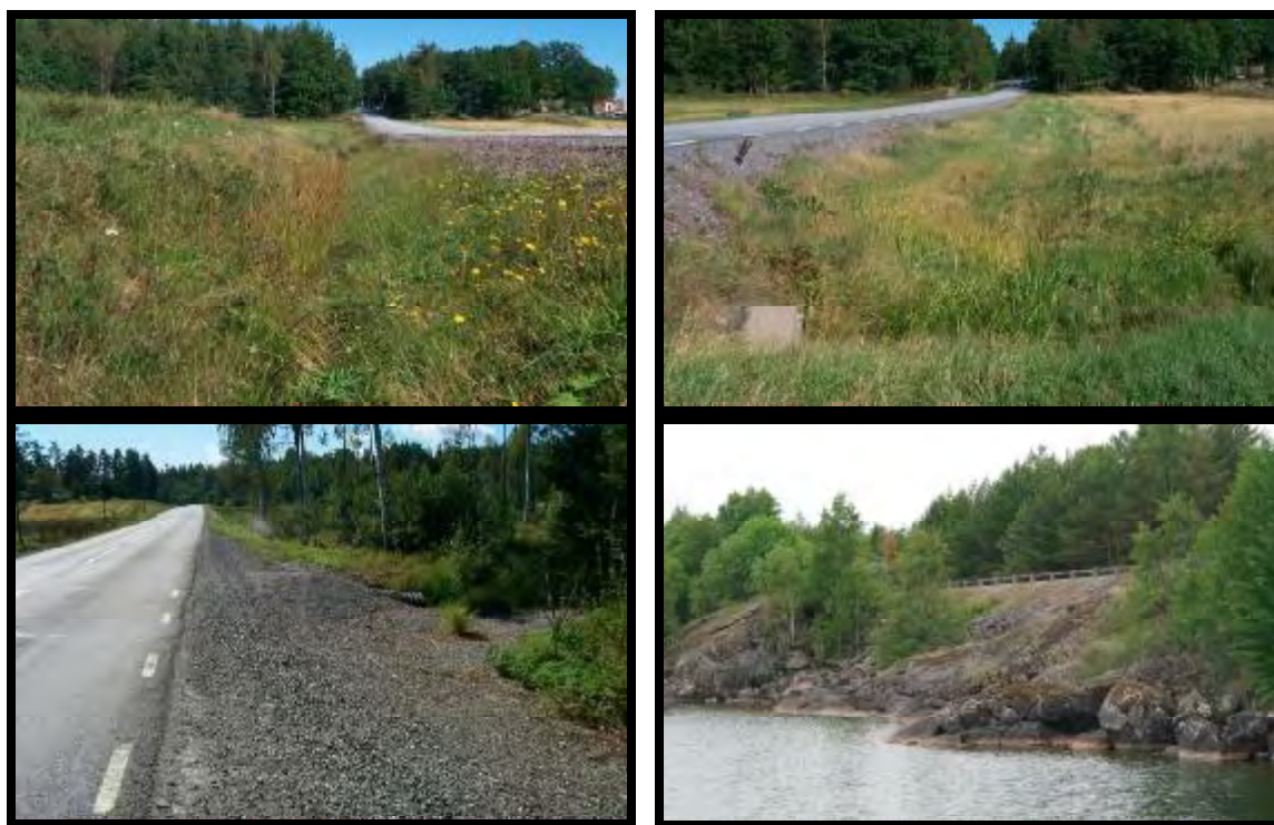
Figur 11. Olika utformning på vägdiken, slänter och översilningsytor som finns längs väg 49 och väg 50.
