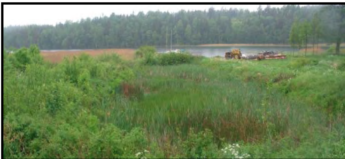
Figur 9. Befintlig damm som kan utnyttjas som fördröjningsmagasin. Forsåån nedströms väg 50.
