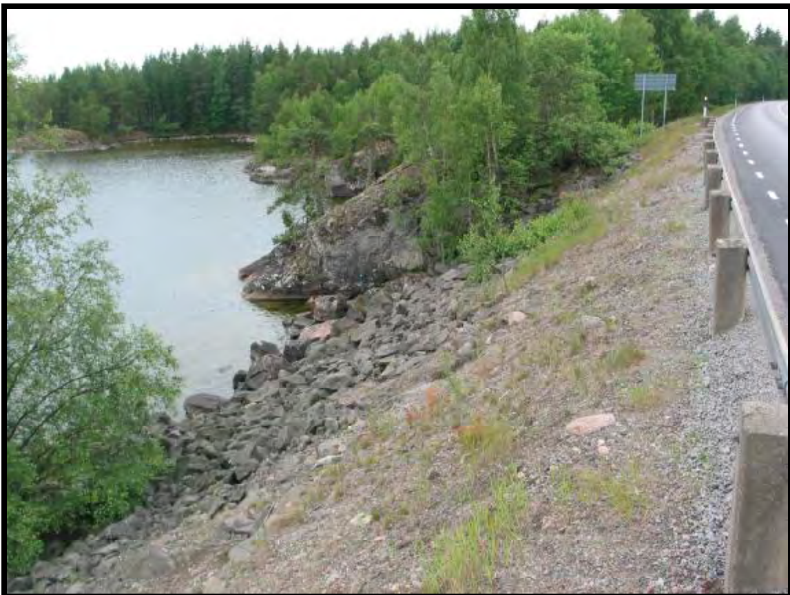
Figur 1. Slänt av sprängsten vilket försvårar vid en eventuell sanering, Stora Koviken precis nedströms väg 49.
